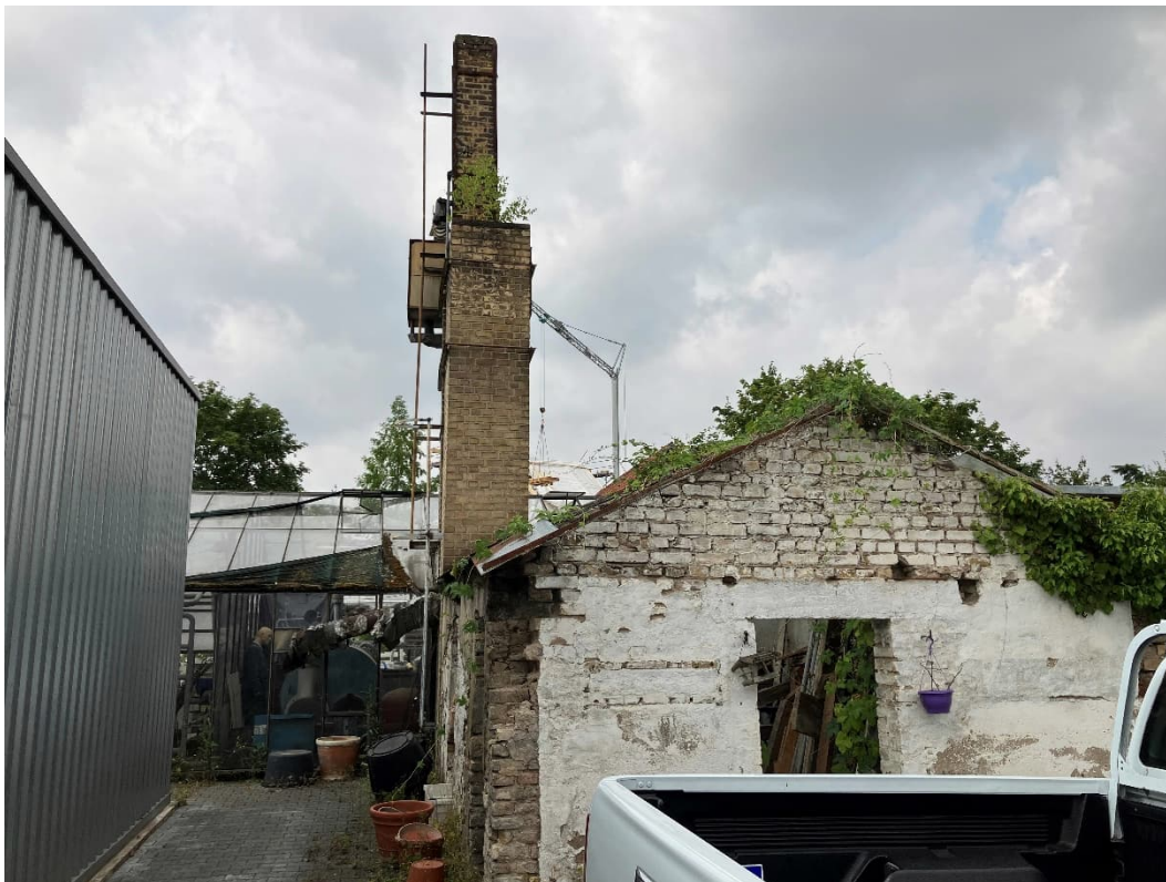
Abb. 5: Alte Backsteingebäude und Gewächshäuser, 10.07.2023
