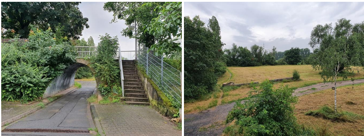
Abbildung 12: Hochwasserschutzdamm (links) und angrenzender Außenbereich (rechts) im Süden des Plangebietes Quelle: eigene Aufnahme
