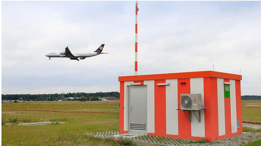
Abbildung 54: Eine GBAS-Bodenstation sendet dem Flugzeug seine genaue Position<sup>172</sup> © Fraport AG
