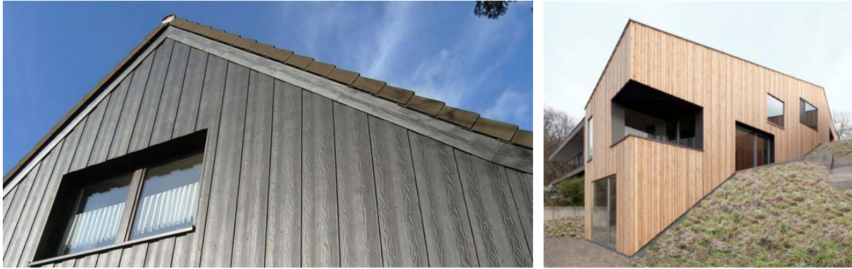
Abbildung 10: links: Beispiel für eine vertikale Fassadengliederung, die bei Neubauten nicht zulässig ist; rechts: Beispiel für eine vertikale Holzschalung, die im Rahmen der Einzelfallprüfung zugelassen werden kann
