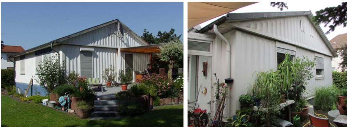
Abbildung 9: vertikale Fassadengliederung der bestehenden MAN-Stahlhäuser
