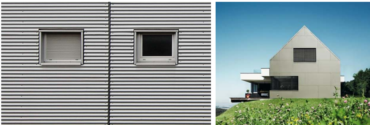
Abbildung 7: für Neubauten mit Ausnahme von Ersatzbauten nicht zulässig sind bspw. Wellblechfassaden (links) und Aluminium-Verbundplatten (rechts)
