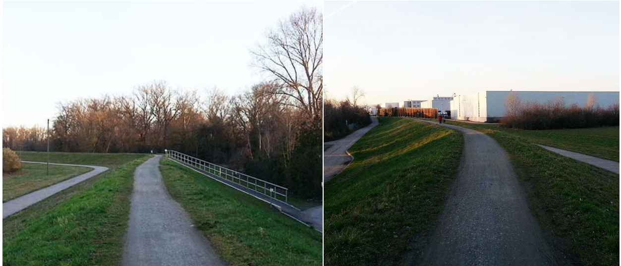
Abbildung 10: Rheindamm südwestlich des Plangebietes
