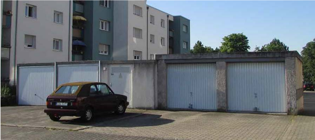
Abbildung 7: Trafostation innerhalb des Plangebietes
