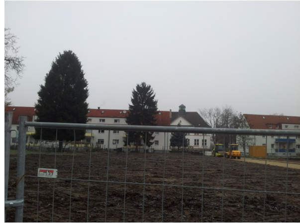
Abb. 3: Rohbodenflächen westlich der Uhlandstraße innerhalb des Geltungsbereichs.
