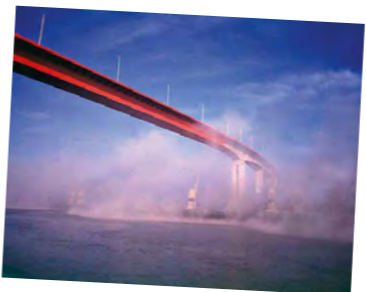
Die Brücke Cheviré Le pont Cheviré
